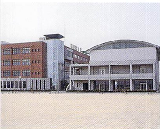
グラウンドより望む本館棟と講堂・体育館棟
